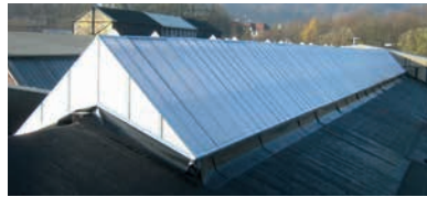
Sattellichtband nach der Sanierung
