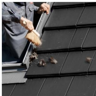
Les feuilles et les autres débris doivent être enlevés des raccords une fois par an pour permettre à l'eau de pluie de s'écouler librement.
