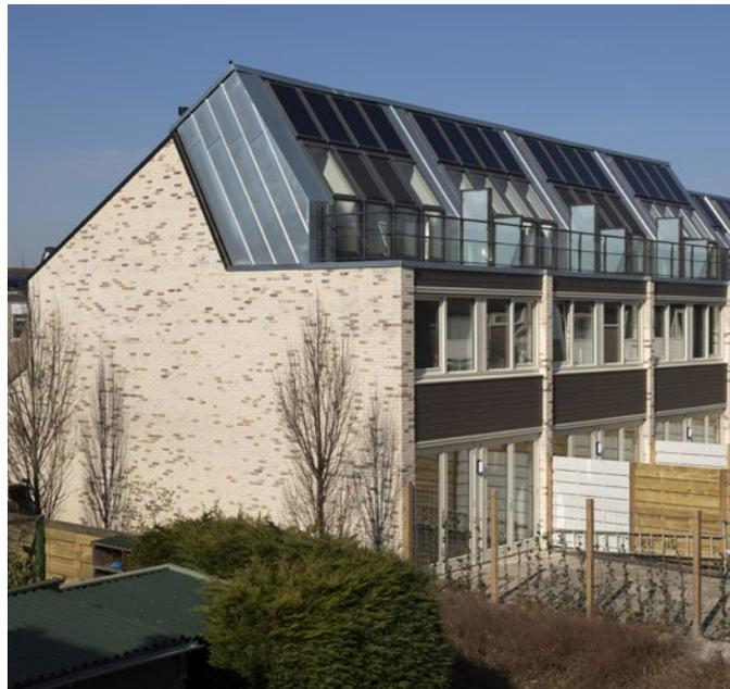
Der Dachbalkon gewährleistet einen einfachen Zugang nach draußen, ohne dass eine herkömmliche Tür in voller Höhe erforderlich ist. Die Höhe wird stattdessen durch eine Kombination aus einem Klapp- Schwing-Fenster in der Dachschräge und mit rechts oder links angeschlagener Balkontür darunter realisiert.
